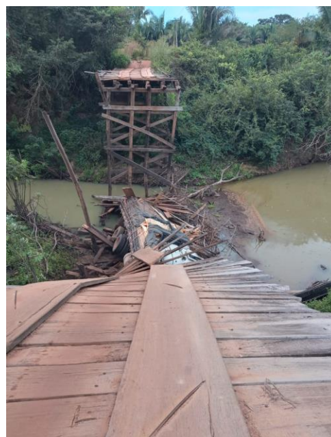
Figura 3. Antiga ponte de madeira sobre o rio Peritoró, zona rural de Pirapemas-MA, destruída após queda de caminhão no início de 2021.
